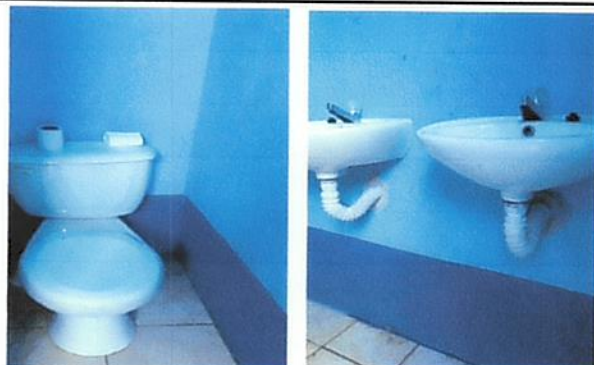
Foto 5: Mantenimiento de baños (sanitarios, lavamanos y accesorios).
