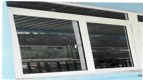
Foto 1: Instalación de ventanas de PVC.
