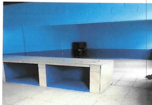
Foto 2: Mejoramiento de instalación de cocina y bodega.
